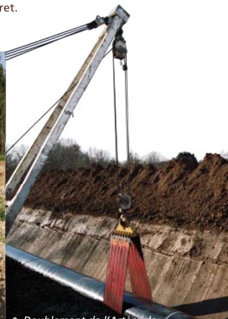
⚡ Doublement de l'Arrière de Guyenne, mise en fouille.
